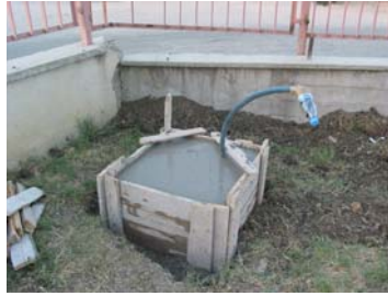
a) Montage der Freifeldstationen auf Betonfundamenten
