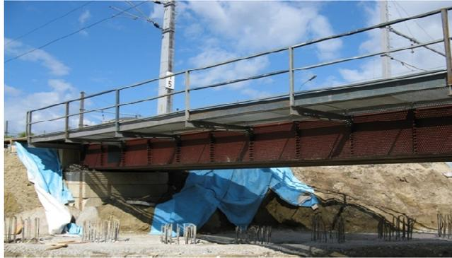
Abbildung 2: Eisenbahnhilfsbrücke-Tulln, SHB 304/12
