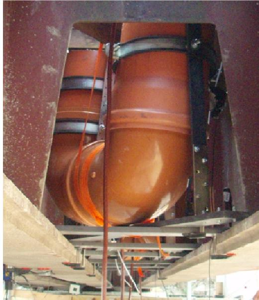
Abbildung 8: Installation der Vertikal-Flüssigkeitstilger bei ÖBB-Eisenbahnbrücke
